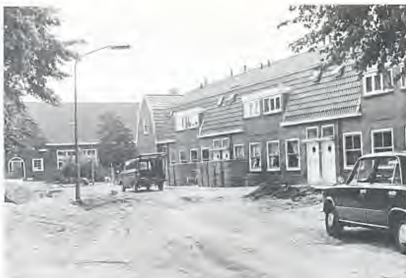
De Wethouder Buningstraat tijdens de renovatie in 1978.
